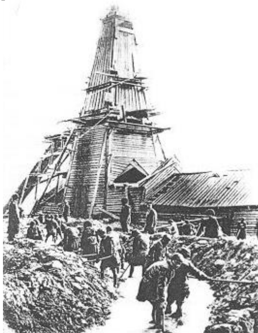
Рисунок 2. Земляные работы у фонтанирующей скважины.
