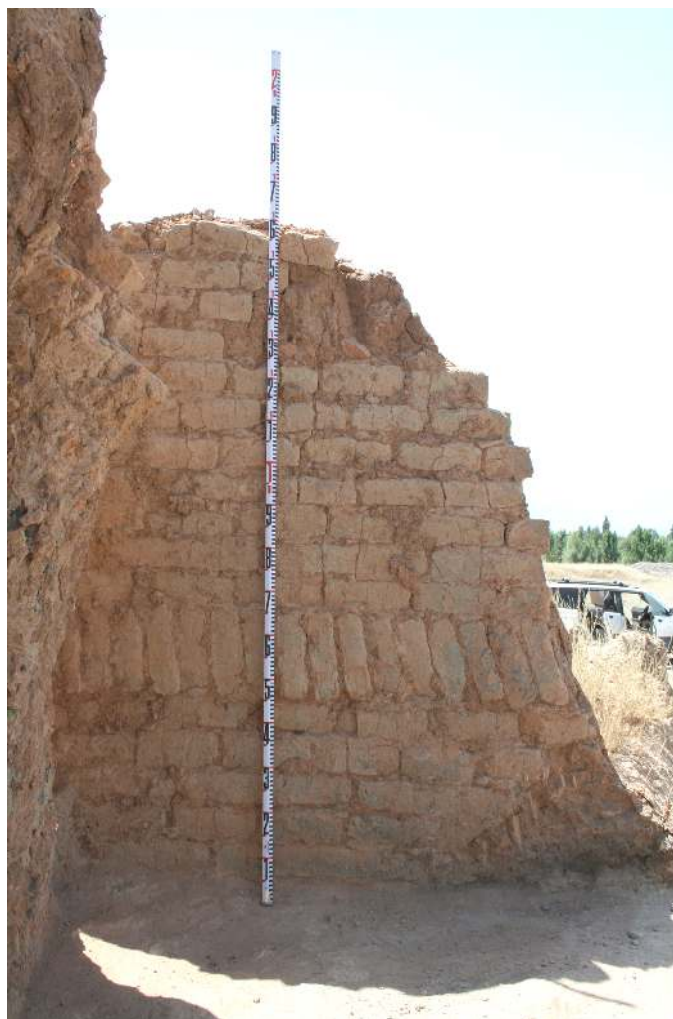
3-сурет. Сортөбе кірпіш күйдіретін пеші. Оттық камераның оңтүстік қабырғасы
