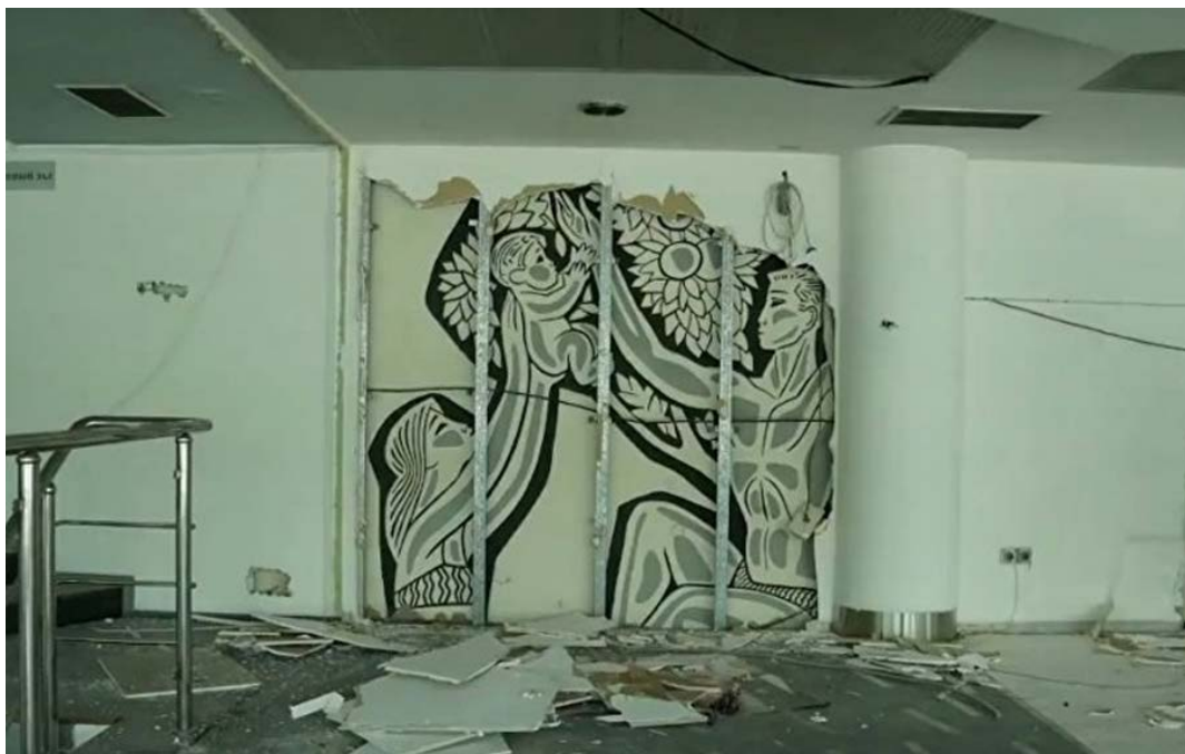
Рис. 3. Фрагменты сграффито Е.Сидоркина в кинотеатре «Целинный», зашитые в гипсокартон во время реконструкции 2000 г. и обнаруженные в 2018 г. при новой реконструкции с целью создания здесь Центра современной культуры.
