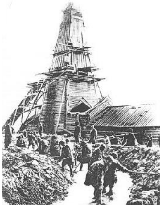
Рисунок 2. Земляные работы у фонтанирующей скважины.
